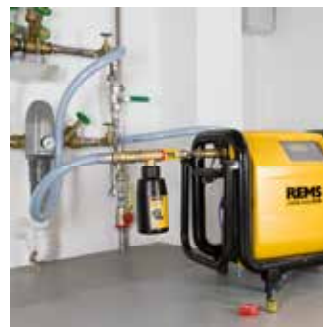
Dezinfekce rozvodů pitné vody
