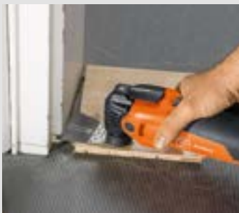
Řezání paralelně s povrchem.
