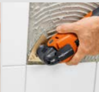
Tvrdokovová rašple odstraňuje lepidlo na dlaždice a zajišťuje rovný povrch.
